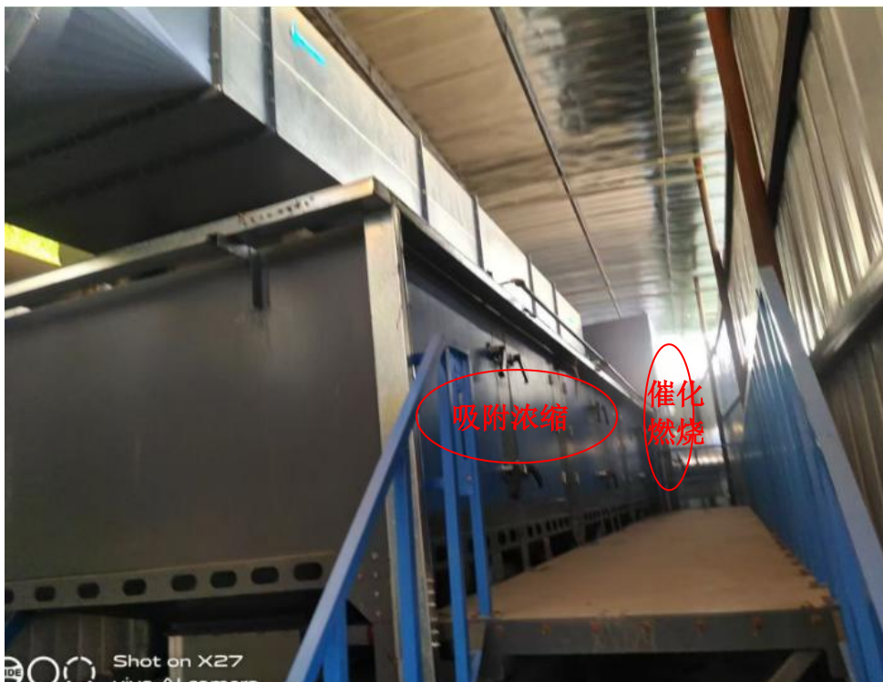
喷涂废气吸附浓缩+催化燃烧装置室内
