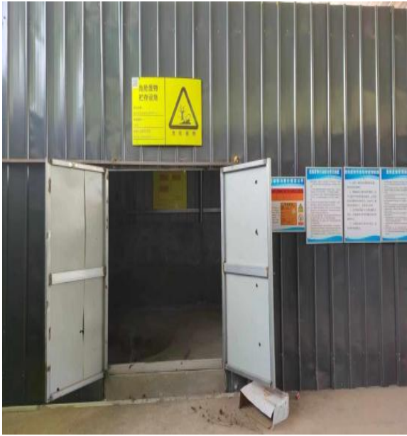
危废贮存点外部
