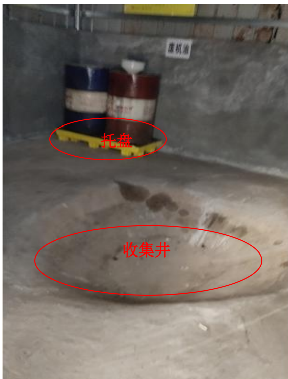
危废贮存点收集井
