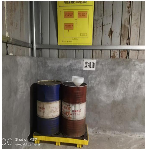
危废贮存点内部
