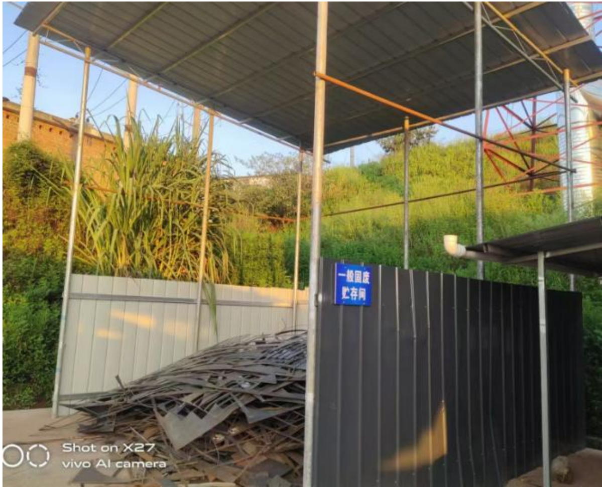
一般工业固体废物暂存间
