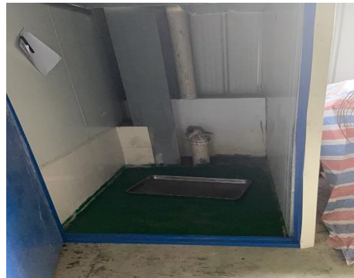
危废暂存间（内部）
