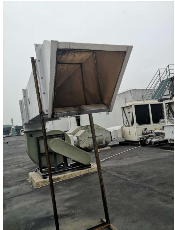
图 3.1-4 两套活性炭吸附箱和 1#排气筒
