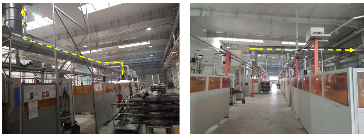
焊接废气排气管道
