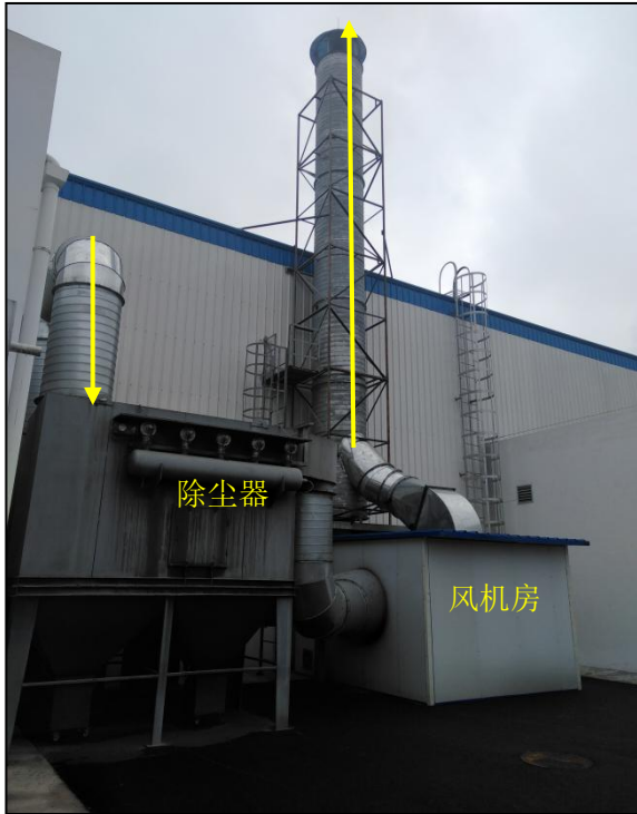
焊接废气排气筒
