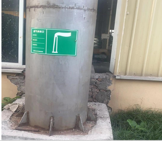
排放口标识（燃烧废气）
