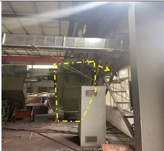
2#布袋除尘器、排气管道
