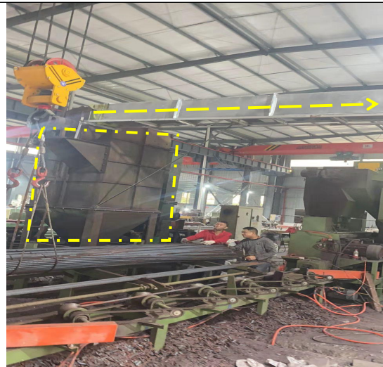
3#布袋除尘器、排气管道
