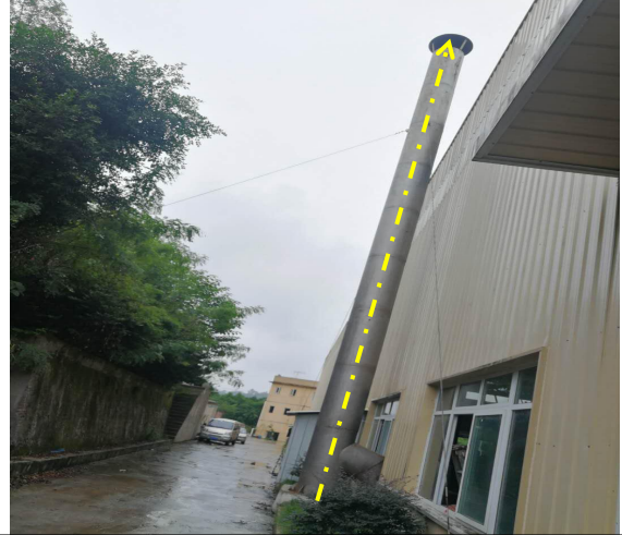
排气筒（燃烧废气）
