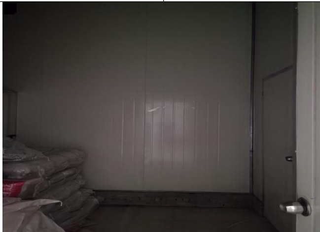
一般固废暂存内部
