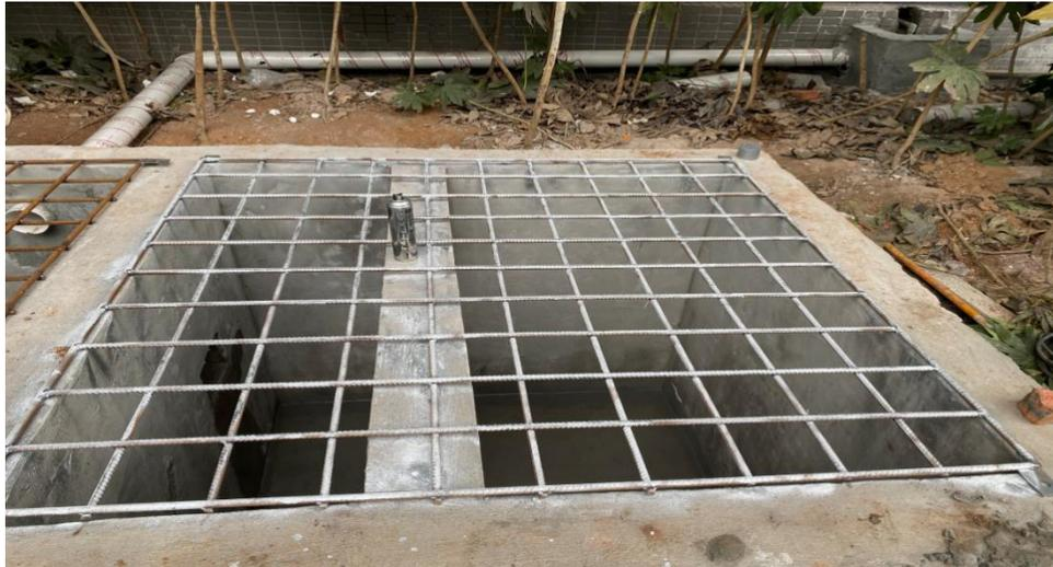
图4.1-2 生产废水处理装置现场图片（沉淀池）
