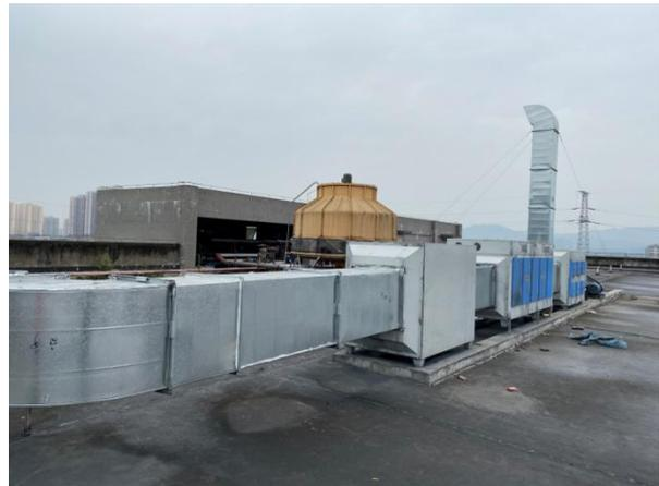
图 4.1-5 硫化塑形废气治理设施
