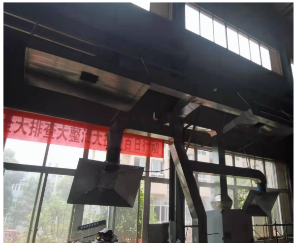
固定焊接工位
