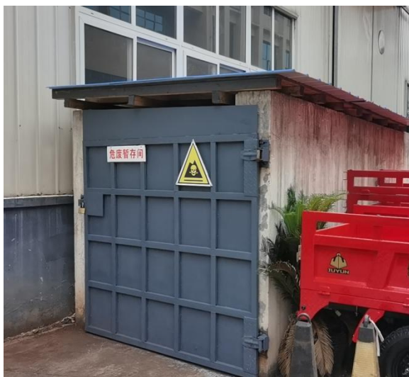
危废间外部情况
