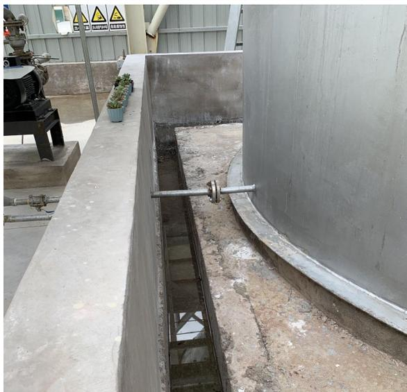
氨水储罐围堰
