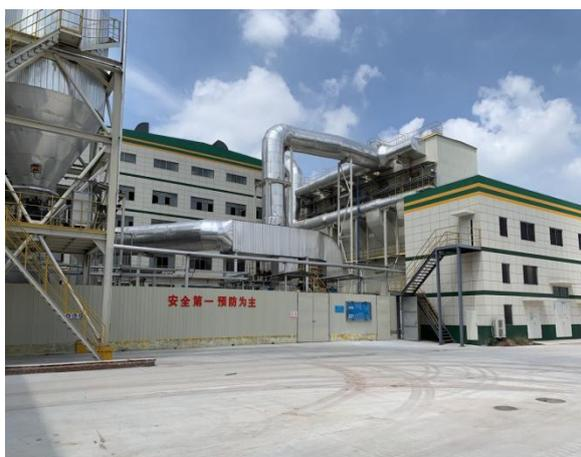
1#窑“电除尘器+SCR脱销反应装置”
