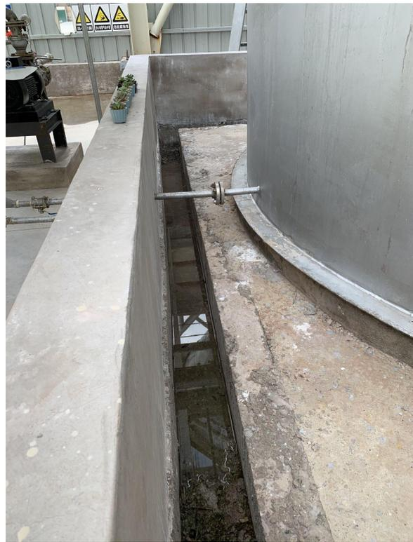
氨水罐围堰及吸收槽
