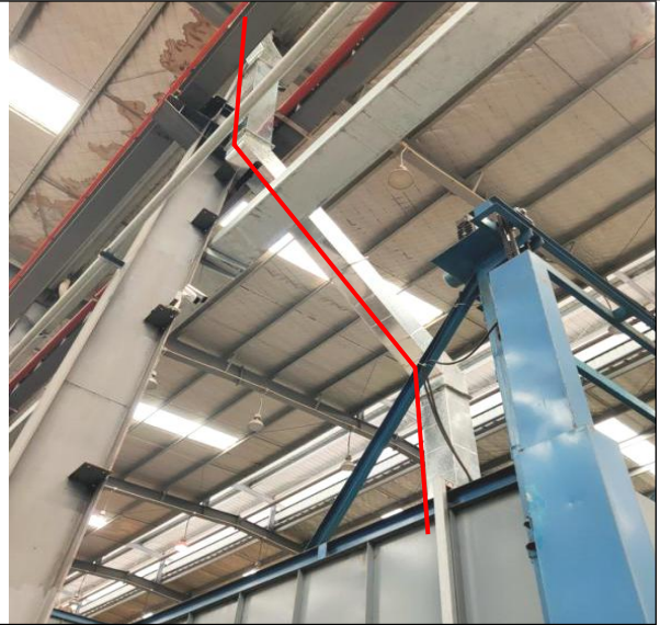
图 3.2-3 时效炉天然气燃烧废气排气筒
