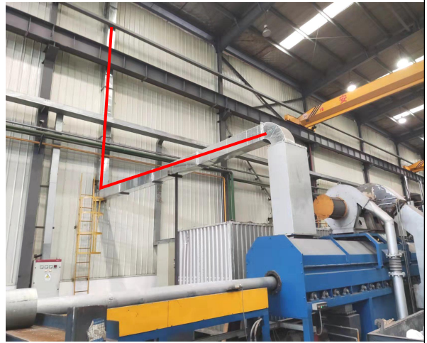
图 3.2-5 加热炉天然气燃烧废气排气筒
