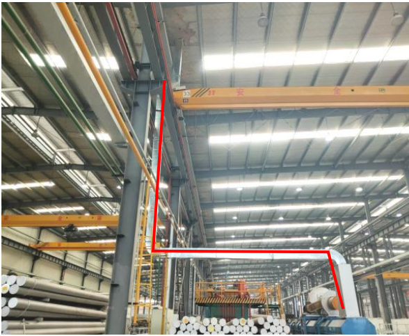
图 3.2-4 加热炉天然气燃烧废气排气筒
