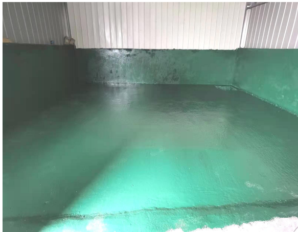
图 3.4-1 危废暂存间防渗及围堰
