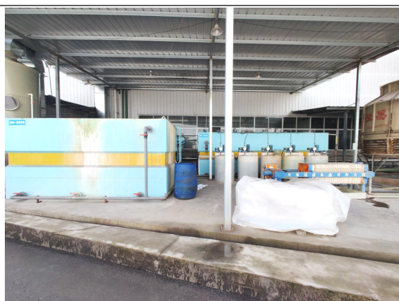
图 3.1-2 污水处理设施
