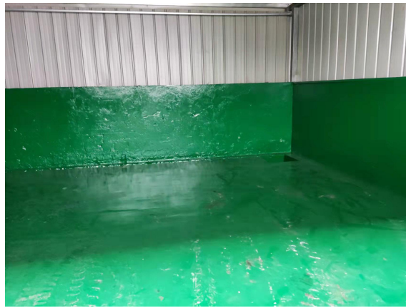
图 3.5-2 危险化学品库防渗处理
