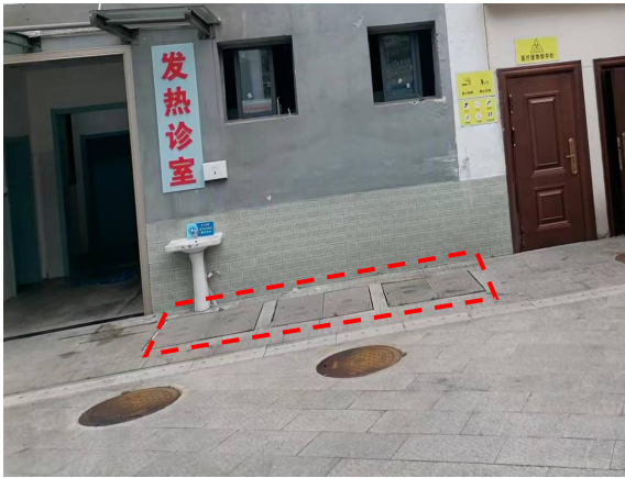
外科楼医疗废水收集池
