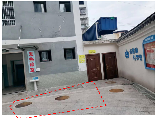
地埋式污水处理设施
