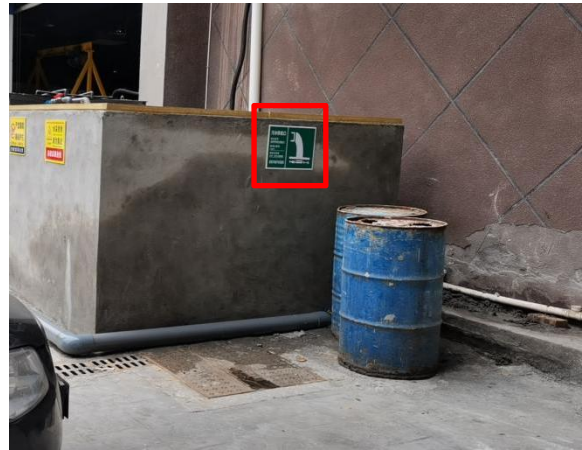
图 3.5-3 废水排放口标牌
